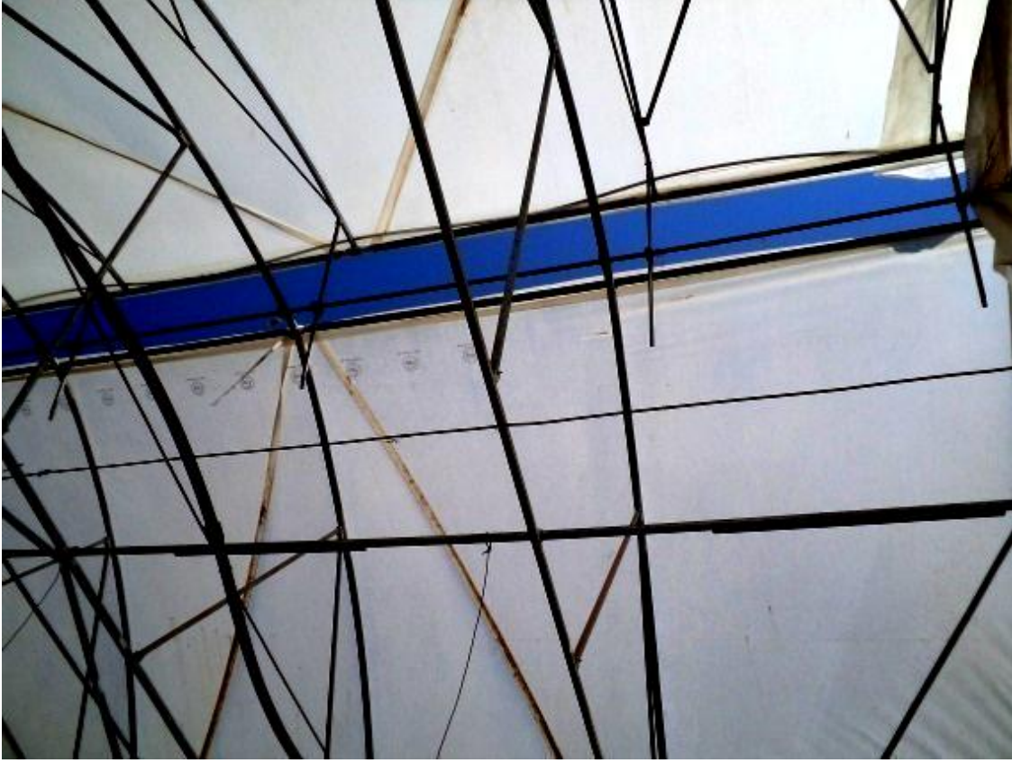
Şekil 4.6 Plastik serada tepeden havalandırma
