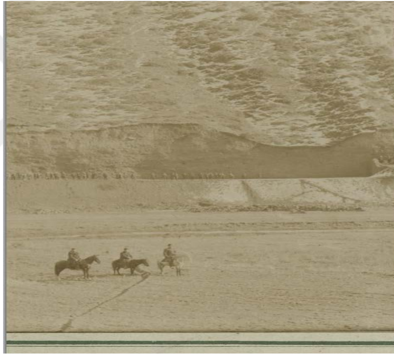
Fotoğraf 3.5 Devebağırardan - Palanka yolu üzerinde yol açma çalışmaları 228
