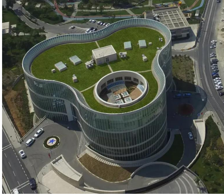
Şekil 2.10. Küçükçekmece belediye binası yeşil çatı sistemi (Yeşil bina dergisi 2014)
